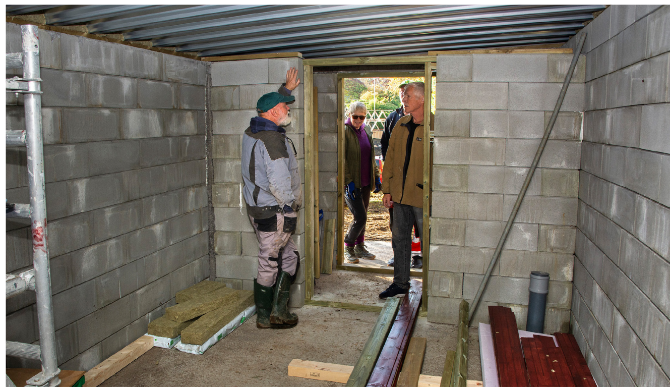
Arbeidet med jordkjelleren er kommet langt.
